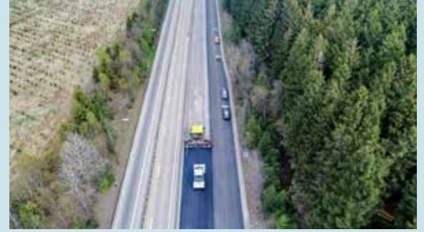
N4: Vernieuwing van de asfaltlaag | Bastenaken, België
