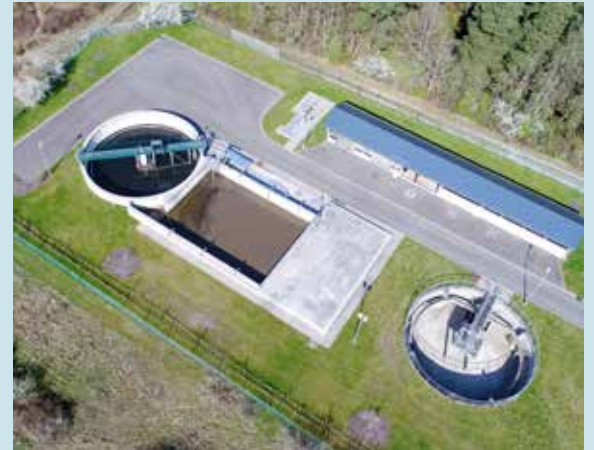
WATERZUIVERINGSSTATION VAN AYE | België
